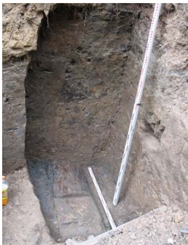
Рис. 12 Раскоп №2. Забутовка плотины. Юг
